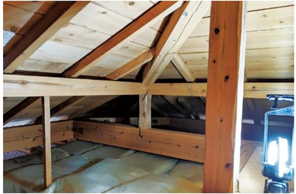
▲こちらは24から27ページで紹介した原田さんのご自宅の屋根裏。設計図から、天井裏への配線工事が可能であることはわかっていたため、施工はスムーズだった。しかし、各室の天井までを不燃材の石膏ボードで覆う「準耐火構造」や、床板を支えるための根太を使わない「根太レス」床など昨今採用例の多い構造は、壁内配線に支障が出るケースもあるという。その意味でも、インストラーへの相談はとにかく早めが吉
